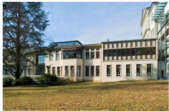
Bâtiment Champ de l'Air Rue du Bugnon 19 1005 Lausanne
